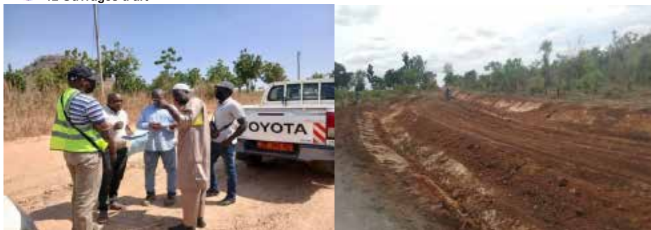
Travaux de reprofilage en cours
