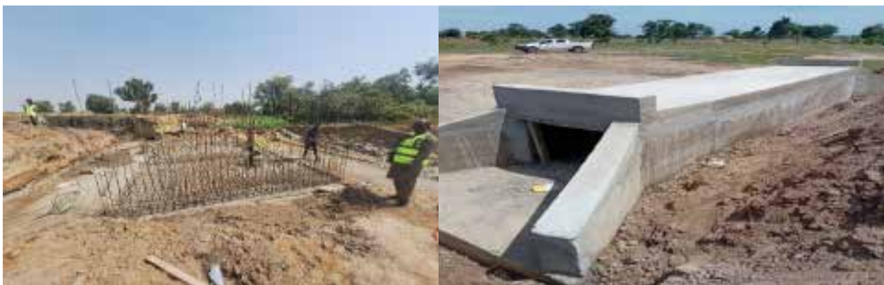
Construction des ouvrages
